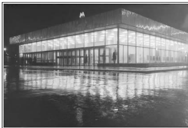
Станция метро «Звёздная» в Петербурге – наземный вестибюль
