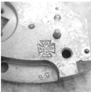
**Иллюстрация 1.** Клеймо фирмы Альфреда Лугрина, поставлено на внутренней стороне моста заводного барабана. Механизм изготовлен для фирмы *Mermond frères*. Фото А. А. Воробьева-Шерышева
