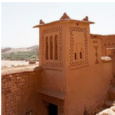
Рисунок 1. Башня периметральной стены. Айт-Бен-Хадду, 2025. Фото автора
