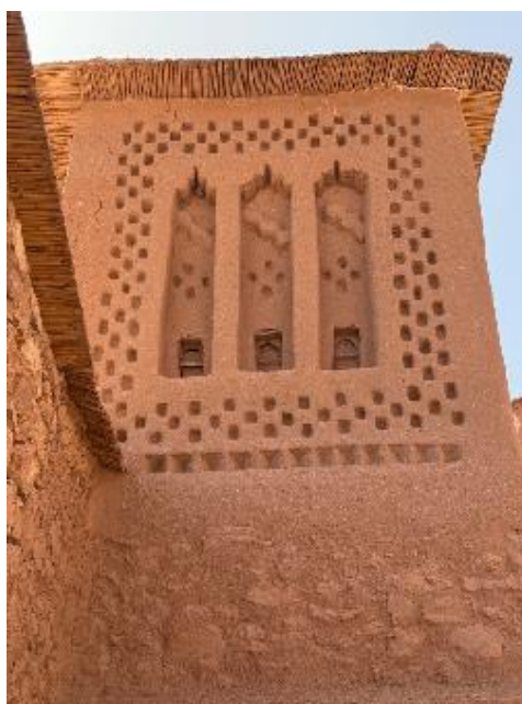
Рисунок 2. Северный фасад башни периметральной стены. Айт-Бен-Хадду, 2025. Фото автора
