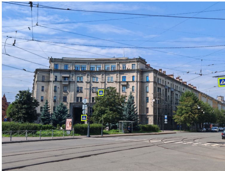
Фото 4. Дом специалистов на Большой Монетной улице, д. 30 в Санкт-Петербурге, предназначавшийся для командного состава ВМФ и работников ЭПРОНа. Построен в 1934-1937 гг. (Фото автора статьи Д. А. Воробьёва, 27 июля 2026 года)
